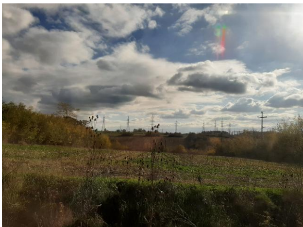
Фотографија 9: Пољопривредне површине и комплекс трафостанице у позадини
